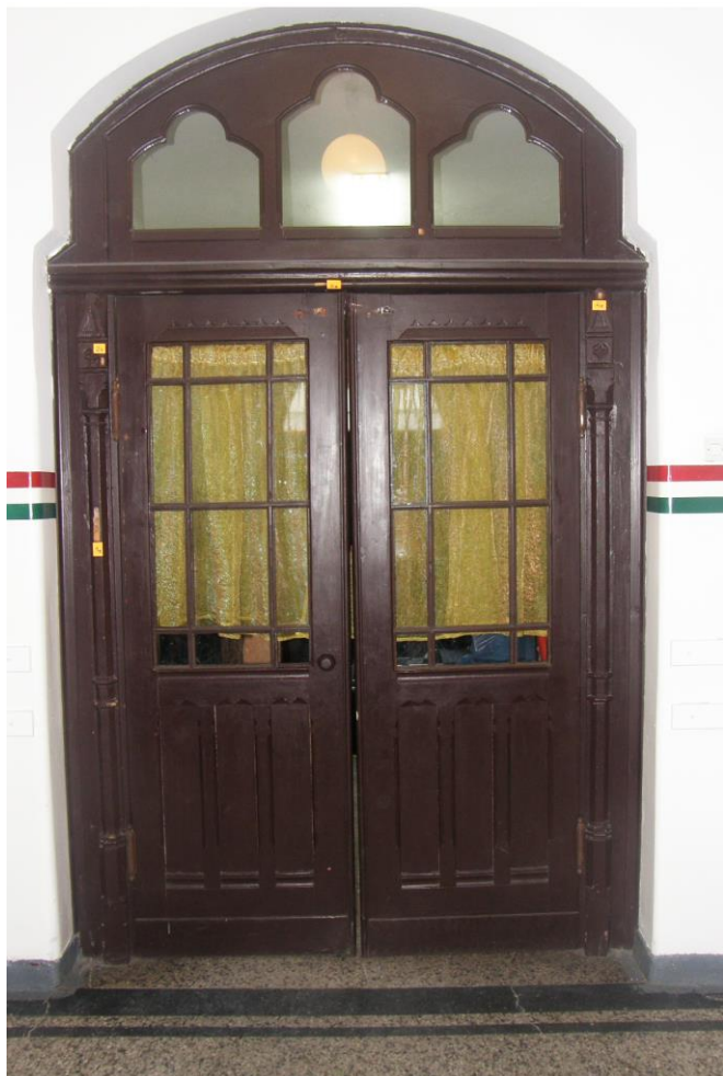
Fot.49 Drzwi wahadłowe drewniane, o konstrukcji ramowo-płycinowej do wyjścia głównego w elewacji południowej
