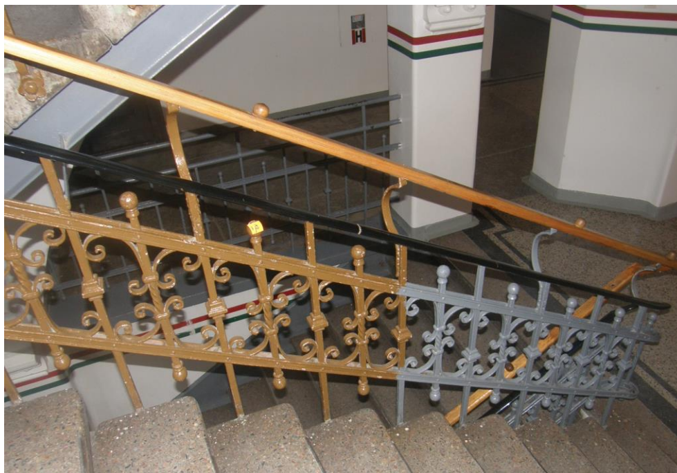
Fot.74 Balustrada metalowa ozdobna, występuje na 2 klatkach schodowych. Poręcze nowo wykonane z wystającymi ogranicznikami/przed zjeżdżaniem/Pomalowana część balustrady na kolor szary i część na kolor ugrowy
