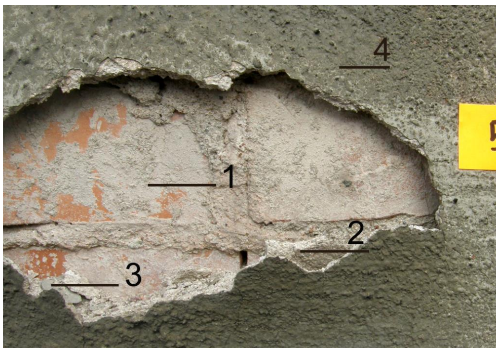
Fot.11 Odkrywka 5, poprzeczny fryz wykonany z zaprawy wapienno cementowej Widoczne warstw; 1-cegła pełna ceramiczna, 2-zaprawa wapienno-cementowa, 3-warstwa malarska jasno szara NCS S 0505-R80B , 4-wtórna mocna zaprawa cementowa
