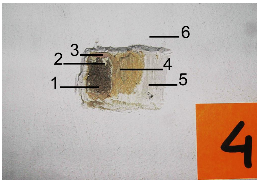
Fot. 15 Odkrywka nr.4 -tynk w hallu na parterze Widoczne warstwy; 1 -drobnoziarnisty tynk wapienno-cementowy, 2-biała kredowa, 3- jasno pomarańczowa NCS S 0507-Y40R 4- żółto pomarańczowa, 5-szpachla gipsowa, 6-biała
