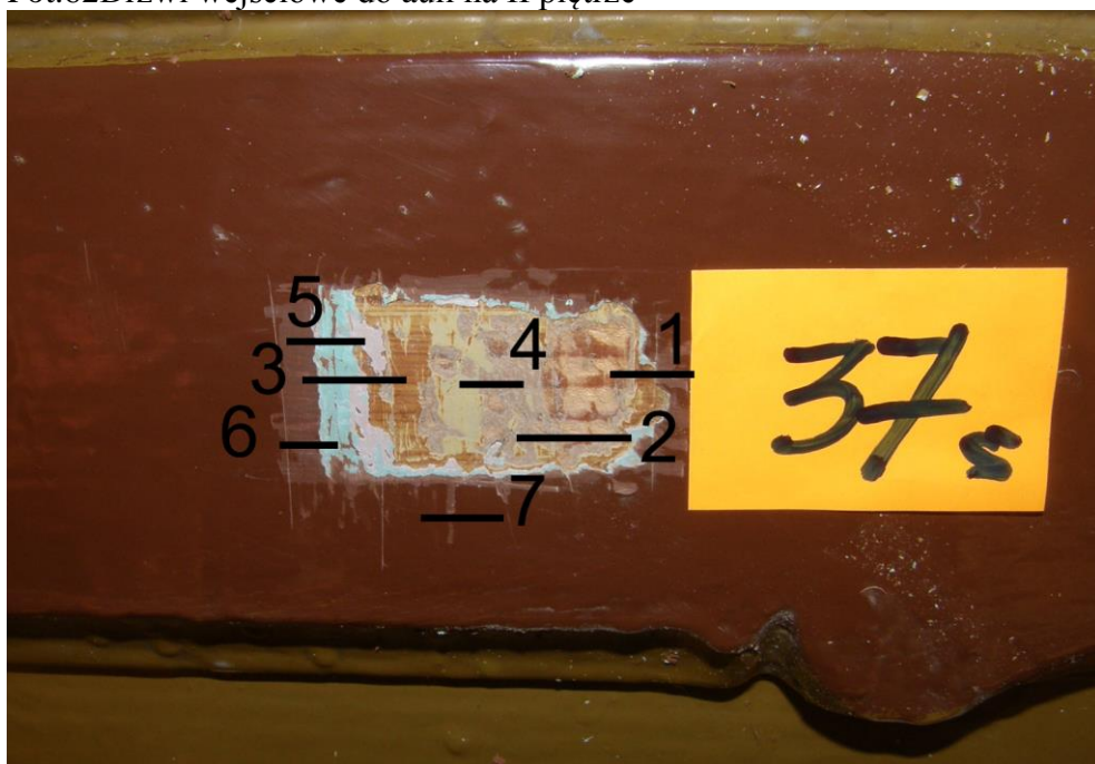
Fot.63 Odkrywka nr.37 Drzwi wejściowe do auli na II piętrze Widoczne; 1-drewno, 2-jasnobeżowa NCS S 1515-Y20R , 3-na piwo, 4-jasnożółta, 5-jasno fioletowa, 6- seledynowa, 7-brązowa
