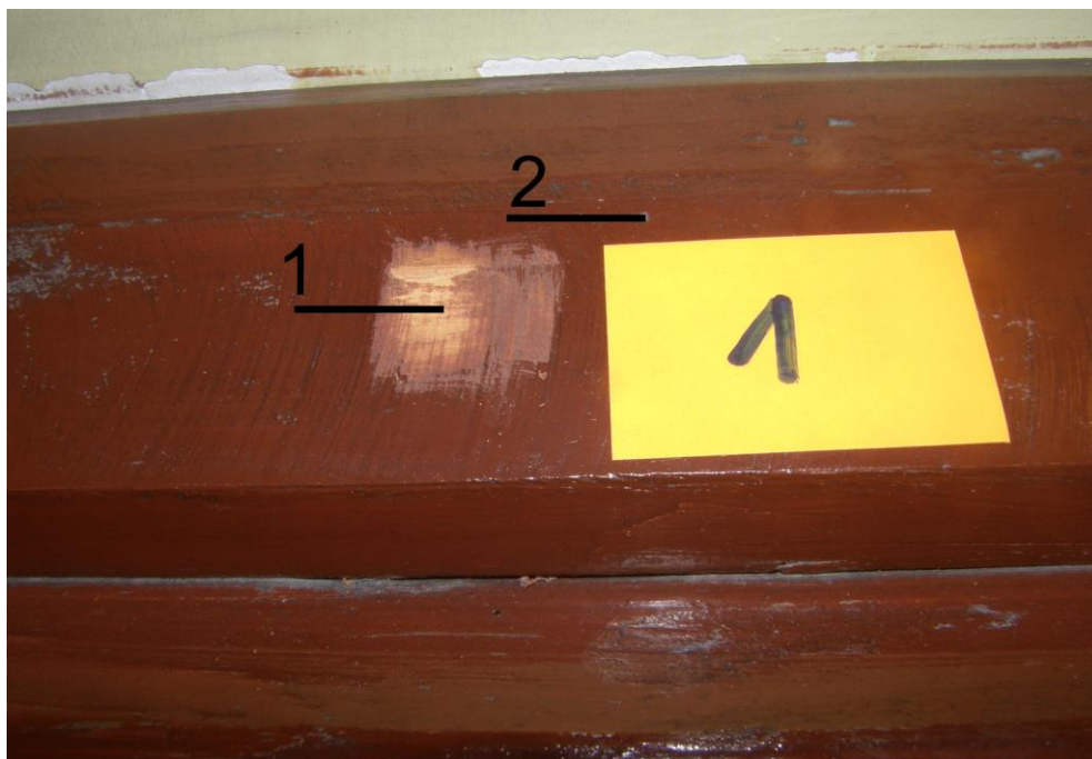
Fot. 72 Odkrywka nr.1 Boazeria ścienna w auli Widoczne; 1-drewno. 2-wtórna warstwa malarska brązowa
