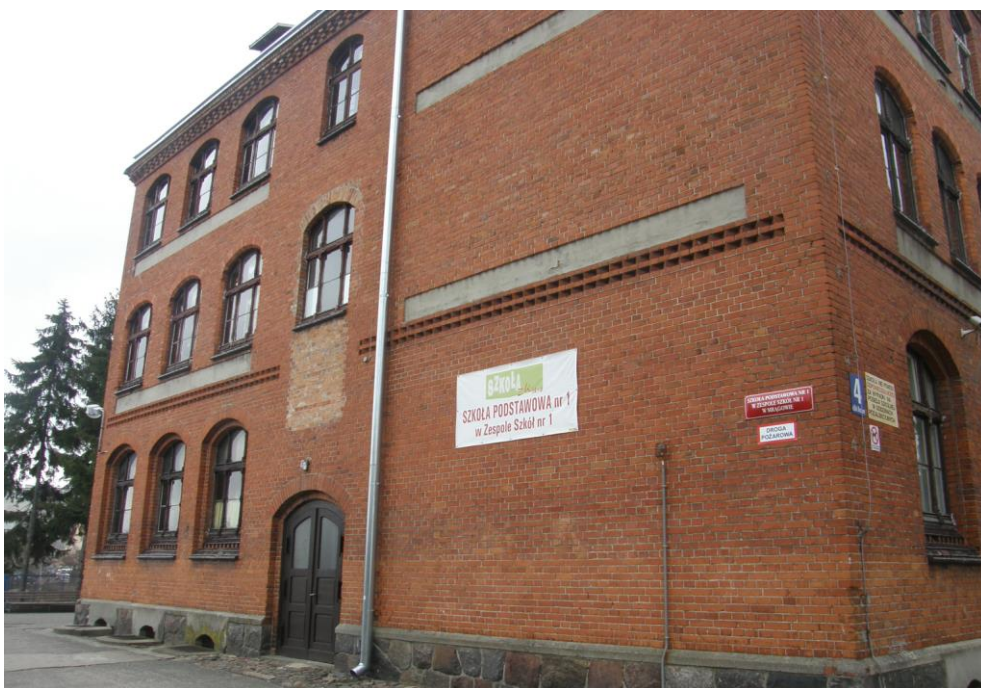
Fot.3 Elewacja zachodnia; widok ogólny, stan zachowania. Widoczne wtórne przemurowanie elewacji pod oknem II kondygnacji. Cokoły wykonane z ciosów z kamienia polnego na zaprawie wapienno cementowej wypełnione mocną półokrągłą spoiną, fragmentami otynkowane nad oknami piwnicznymi
