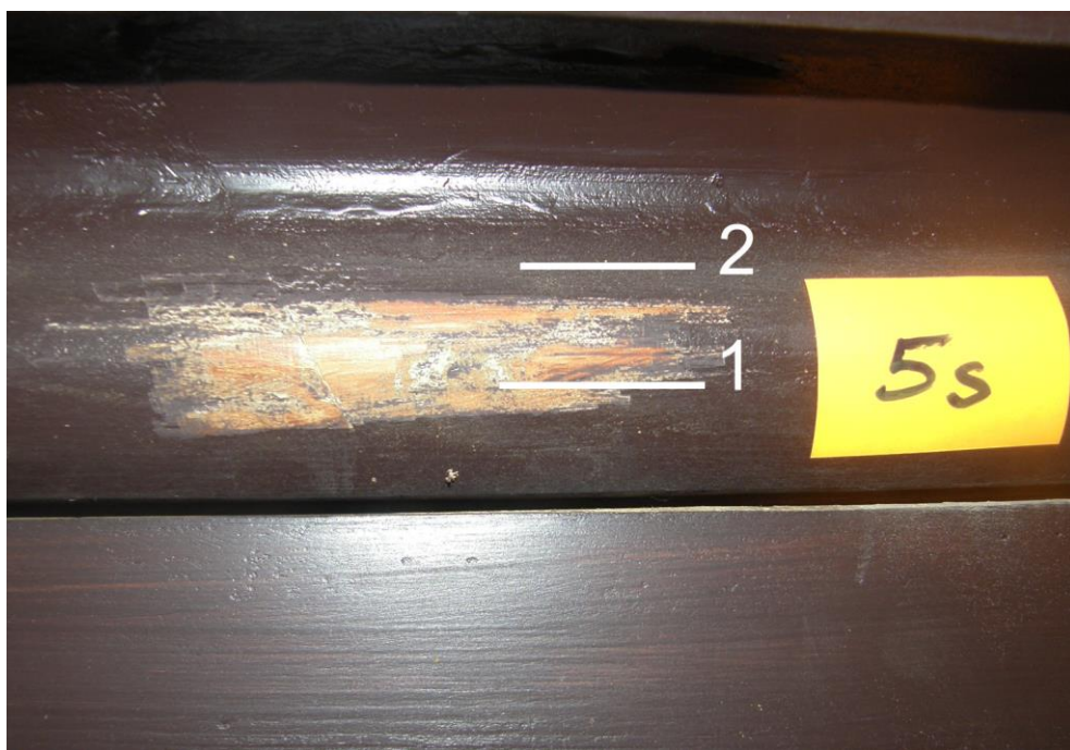
Fot.50.Odkrywka nr.5 Drzwi wahadłowe do wyjścia głównego elewacji południowej, odczyszczzone i pomalowane na nowo. Widoczne warstwy; 1-drewno, 2-wtórna ciemno brązowa
