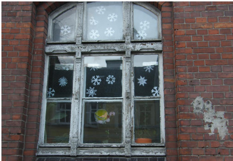
Fot.31 Historyczne okno łukowe drewniane; skrzynkowe sześciokrzydłowe (trójdzielne, dwupoziomowe); skrzydła podślemienia dzielone poziomą szczebliną na dwie kwatery; opracowanie snycerskie: ślemiona sfazowane w dolnej części, zdobione rozetkami; słupki zdobione pilasterkami. Okno usytuowane na parterze z prawej strony elewacji południowej /frontowej/.
