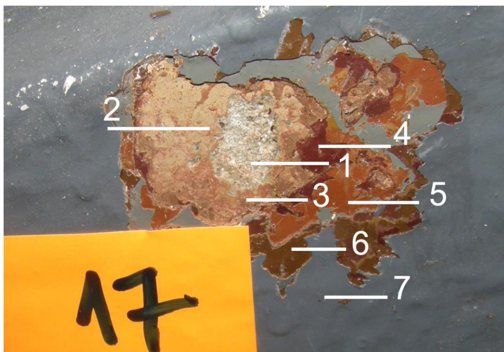
Fot.23 Odkrywka nr.17–lamperia na cokole klatki schodowej. Widoczne warstwy malarskie; 1-zaprawa wapienno-cementowa, 2- jasno beżowa NCS S 1005-Y70R , 3-pomarańczowa, 4-bordowa, 5-brązowa, 6-ciemno brązowa, 7-ciemno szara
