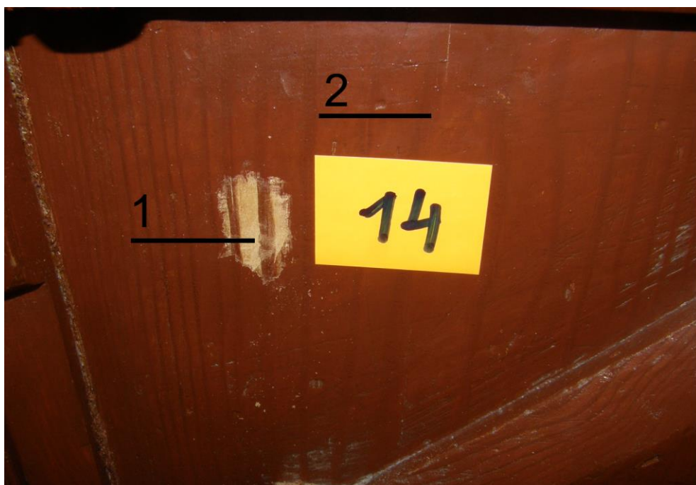
Fot. 73 Odkrywka nr.14 Boazeria ścienna w auli. Widoczne; 1-drewno., 2 - wtórna warstwa malarska brązowa
