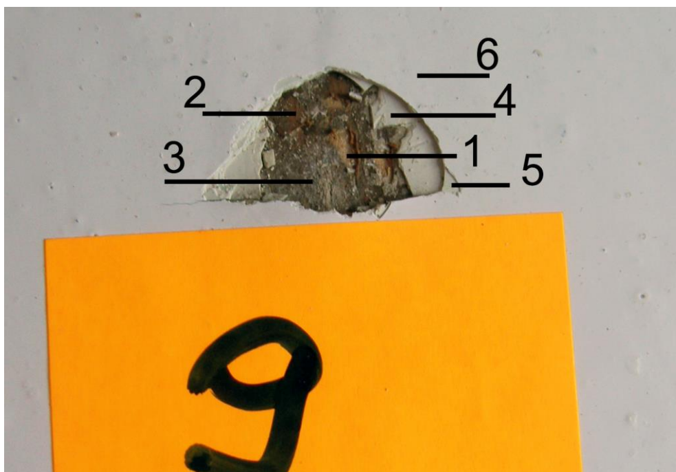
Fot.38 Odkrywka nr.9 Historyczne okno drewniane na klatce schodowej B, spocznik między I/II piętrem; parapet okienny. Widoczne warstwy; 1-drewno, 2- ciemno brązowa NCS S 6030-Y30R, 3-szarozielona, 4-biała, 5-biała, 6-biała
