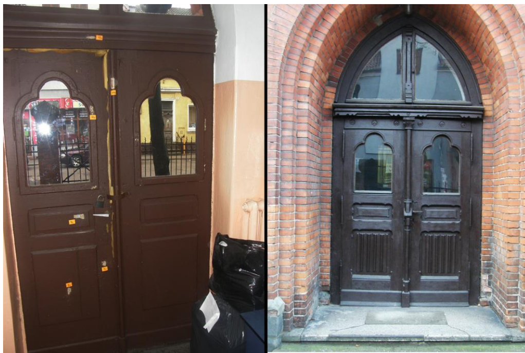
Fot.44 Drzwi: drewniane, o konstrukcji ramowo-płycinowej. Drzwi wejściowe w elewacji południowej dwuskrzydłowe o skrzydłach zakończonych prosto, ze stałym śłemeniem oraz przeszklonym nadświetlem o kształcie ostrołukowym; Od lewej strona wewnętrzna z warstwami malarskimi, z prawej zewnętrzna drzwi odczyszczane i pomalowane na kolor ciemny brązowy. Wszystkie drzwi na elewacjach północnej, zachodniej i południowej odczyszczane do drewna i pomalowane na nowo na kolor ciemno brązowy.
