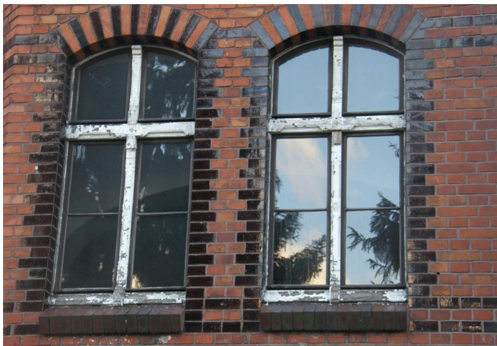
Fot.30 Historyczne okno łukowe drewniane; skrzynkowe czteroskrzydłowe (dwudzielne, dwupoziomowe) skrzydła podślemienia dzielone poziomą szczebliną na dwie kwatery; opracowanie snycerskie: ślēmiona sfazowane w dolnej części, zdobione rozetkami; słupki zdobione pilasterkami. Okno usytuowane na parterze z lewej strony elewacji zachodniej
