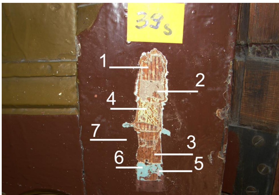
Fot.64 Odkrywka nr.38 Drzwi wejściowe do auli na II piętrze Widoczne; 1-drewno, 2-jasnobeżowa NCS S 1515-Y20R , 3-jasno żółta 4-jasno zielona, 5-orzech średni
