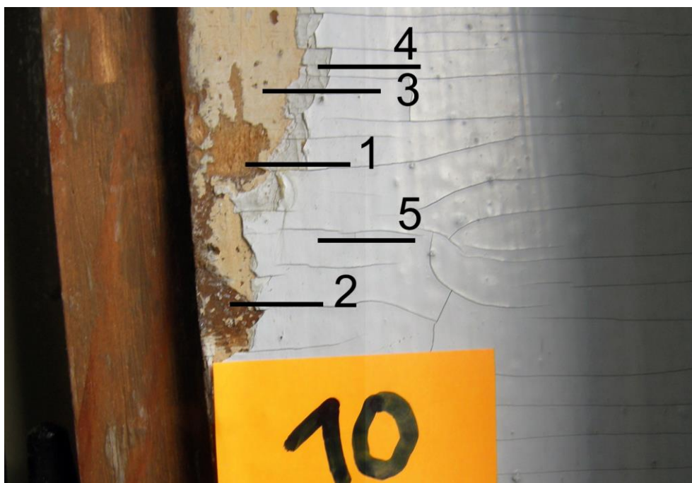
Fot.39 Odkrywka nr.10 Historyczne okno drewniane /futryna / na I piętrze w sali nr.16/ język polski/ Widoczne warstwy; 1-drewno, 2- ciemno brązowa NCS S 6030-Y30R, 3-jasna beżowa, 4-szara, 5-biała
