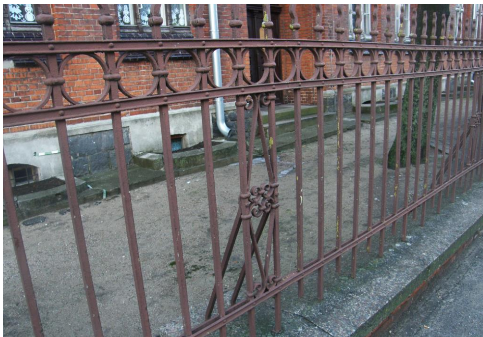
Fot.78.Ozdobne metalowe ogrodzenie z murowanymi słupkami występuje od południowej strony posesji szkoły, część zachodnia i północna ogrodzona siatką metalową z metalowymi słupkami
