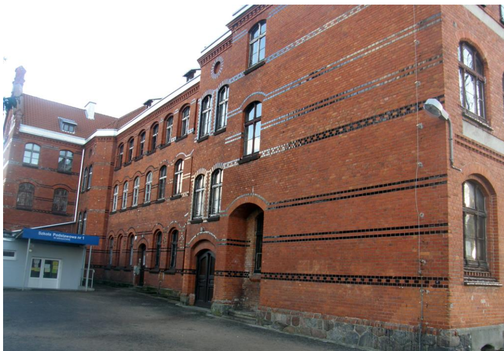
Fot.4 Elewacja północna –widok ogólny, stan zachowania Ozdobne poziome pasy z cegły glazurowanej w kolorze ciemno brązowym/nie występują na elewacji zachodniej i frontowej/. Cokoły wykonane z ciosów z kamienia polnego na zaprawie wapienno cementowej, wypełnione mocną półokrągłą spoiną.
