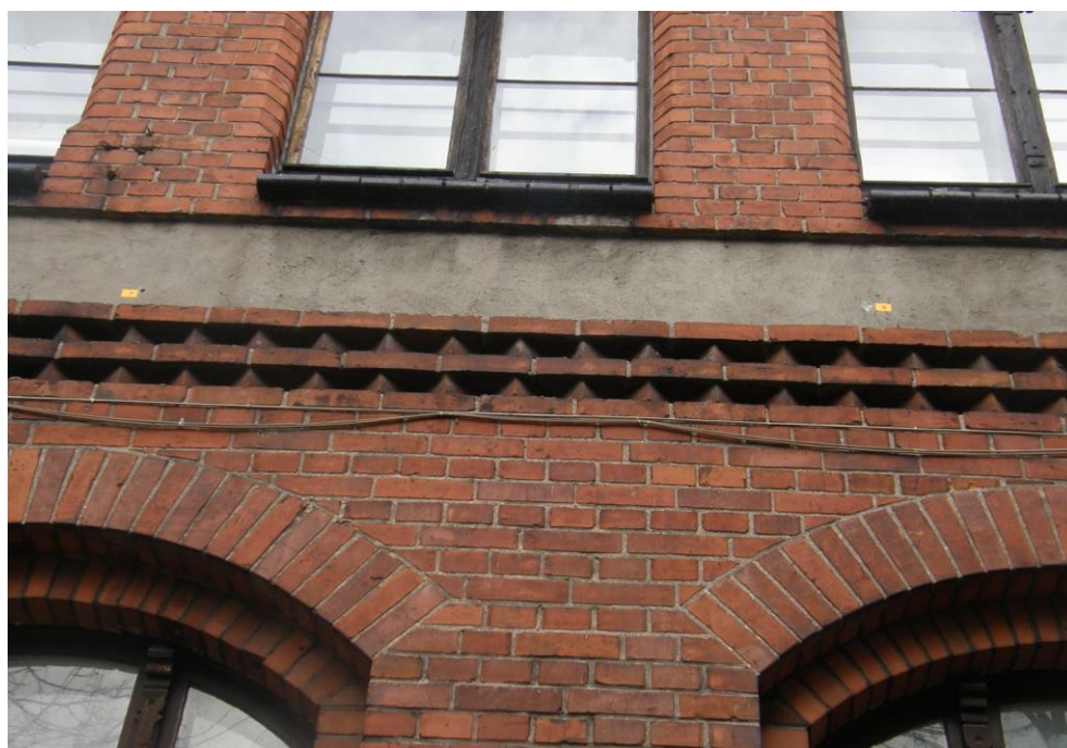
Fot 9. Elewacja południowa (frontowa) z cegły licowej z poprzecznym fryzem wykonanym z zaprawy wapienno-cementowej
