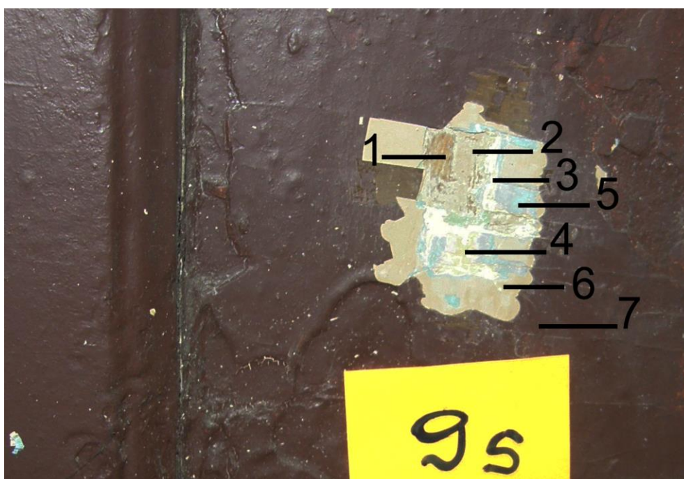
Fot.47 Odkrywka nr. 9, drzwi wejściowe z prawej strony elewacji południowej/frontowej/ Widoczne warstwy; 1-drewno, 2- warstwa beżowa NCS S 1515-Y20R, 3biała. 4- jasno żółta, 5-niebieska, 6-ugrowa, -brązowa ciemna
