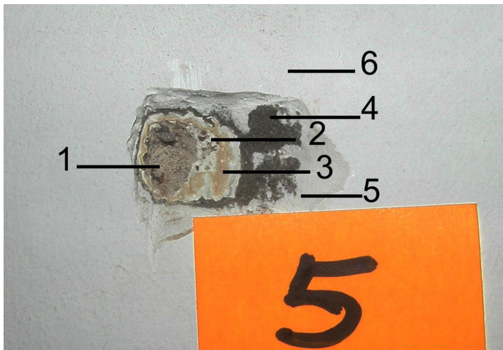
Fot.16 Odkrywka nr.5 -tynk w hallu na parterze Widoczne warstwy; 1 -drobnoziarnisty tynk wapienno-cementowy, 2-biała kredowa, 3- jasno pomarańczowa NCS S 0507-Y40R , 4- cienki tynk cementowy, 5-szpachla gipsowa, 6-biała
