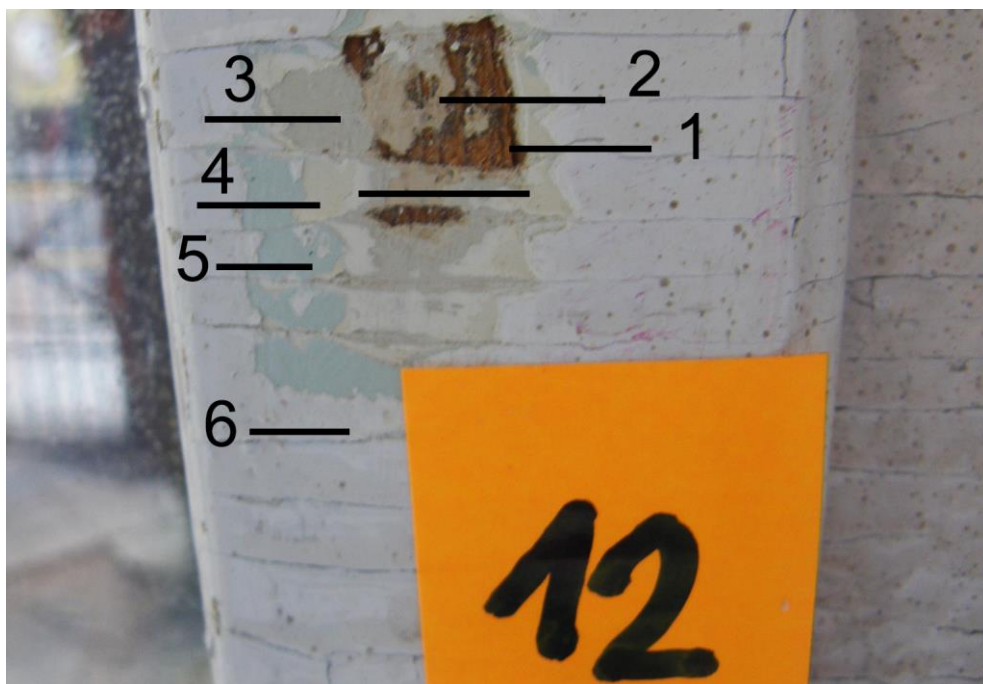
Fot.41 Odkrywka nr.12 Historyczne okno drewniane /futryna / na parterze w sali nr. 8. Widoczne warstwy; 1- ciemno brązowa NCS S 6030-Y30R , 2-jasna beżowa, 3-szara, 4-jasna kremowa, 5-jasno niebieska, 6-biała
